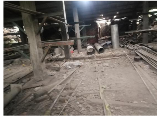
南地块仓库 2 内部
